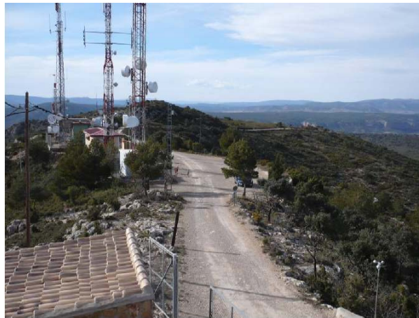
Figura 12. Zona de comunicaciones en el pico del Remedio donde queda instalado el gateway de comunicaciones
